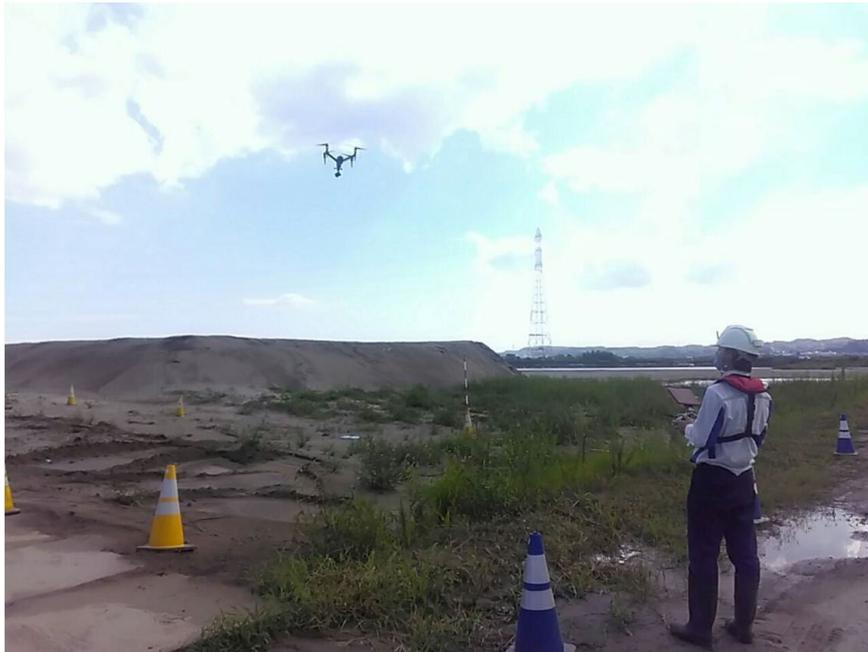
ドローンによる 空中写真測量状況
